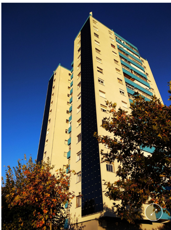
Vista de la fachada fotovoltaica instalada en la torre del renovado bloque de viviendas que ha logrado disminuir la factura energética de sus inquilinos. CONSORCIO PROYECTO EUROPEO REMOURBAN
