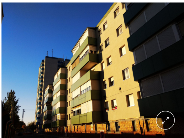
La torre y los bloques de Paseo Arco de Ladrillo tras la premiada intervención. El plan Remourban ha sustituido la red de distribución de calefacción para mejorar su aislamiento y reducir las pérdidas. CONSORCIO PROYECTO EUROPEO REMOURBAN
