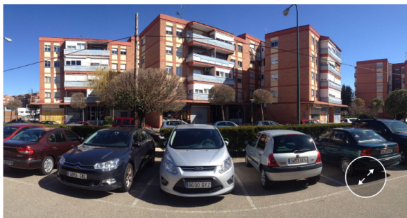
Imagen que muestra cómo eran los bloques antes de la intervención CONSORCIO PROYECTO EUROPEO REMOURBAN
