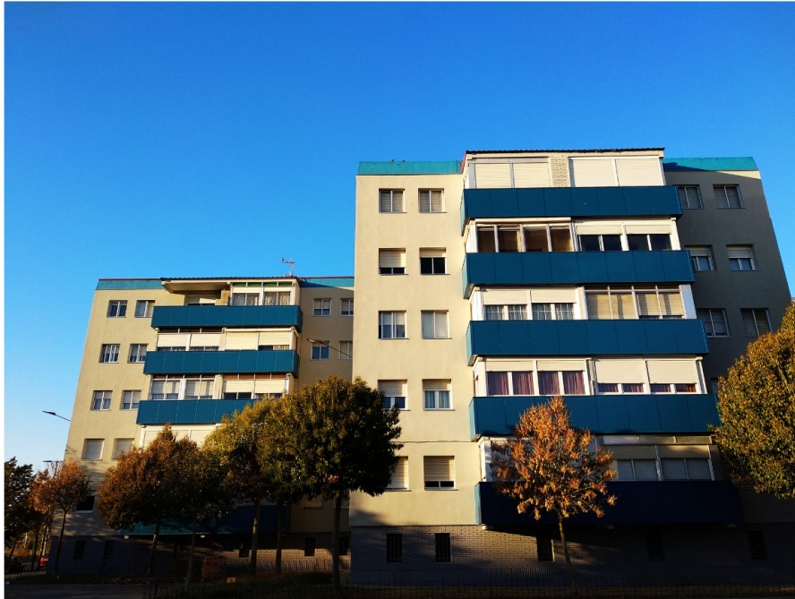
Los bloques de la calle Camaño tras la intervención: las fachadas fotovoltaicas producen energía y reducen el consumo y cuentan con aislamiento térmico y aislamiento en cubierta. CONSORCIO PROYECTO EUROPEO REMOURBAN
